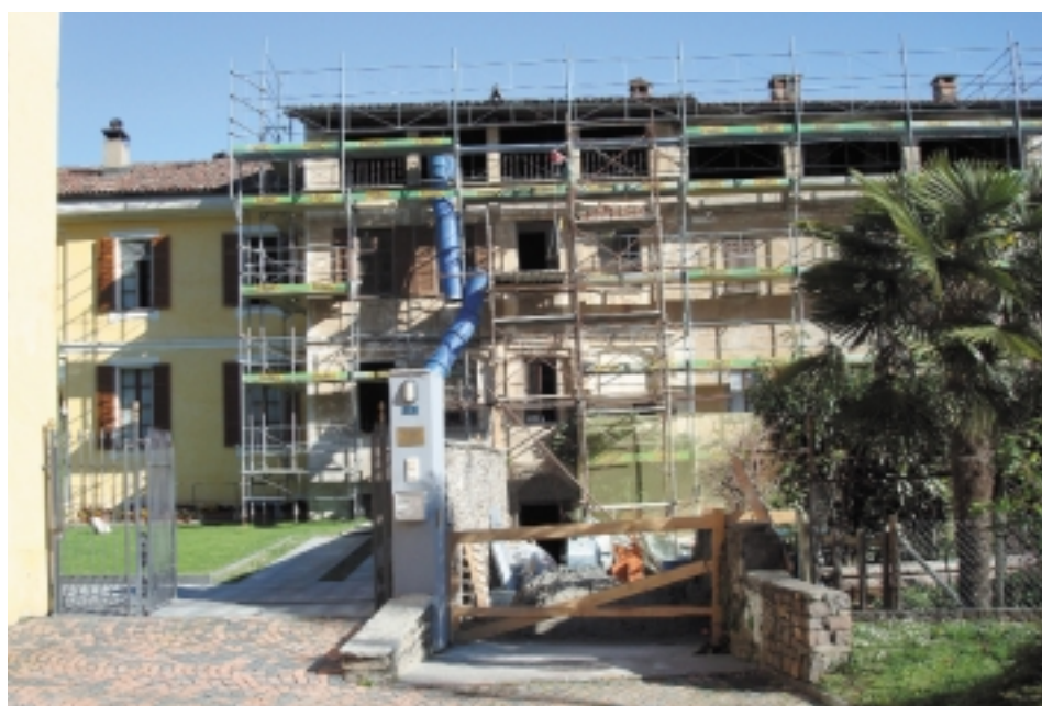
Inizio dei lavori di restauro nelle due case contigue alla nostra sede di Viglio
